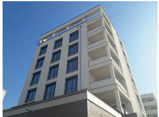
Für ein Wohnareal an einer mehrgleisigen Bahnanlage in Frankfurt wurden 135 Lüftungspaneel-Kastenfenster mit 39 dB Schalldämmmaß (teilgeöffnet) eingebaut. Foto: EFT
